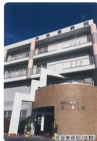
奈良東病院(外観)
